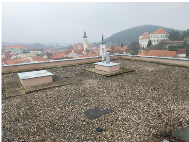
Pohled na plochu střechy se stabilizační a ochrannou vrstvou - fotografie z místního šetření provedeného dne 26. 02. 2025
